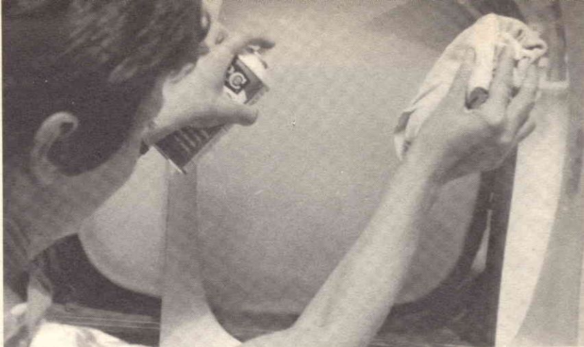
Fig. 3 - Sempre in merito agli Spray, che non possono mancare in alcun laboratorio, è da segnalare lo «E-Z Slip - Rawn Company» che assicura l'accuratissima pulitura a specchio di tubi, di maschere, di schermi anti-implosione.
